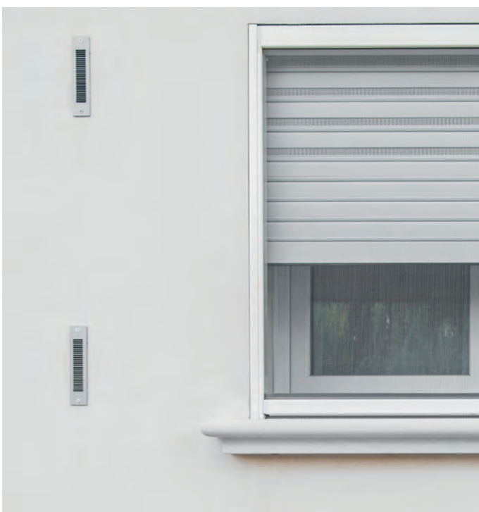
GRIGLIE DI VENTILAZIONE ESTERNE
