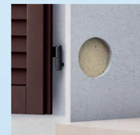
Particolare blocchetto in purenit inserito all'interno alla spalla per fissaggio cardini.
